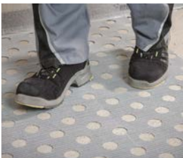
7 RAUTHERM SPEED plus renova Matte am Untergrund flächig andrücken.
