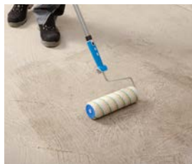
1 Untergrund mit einer geeigneten Grundierung vorbehandeln und Trocknungszeit einhalten.
