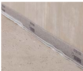
2 REHAU Randdämmstreifen befestigen.
