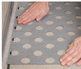
5 RAUTHERM SPEED plus renova Matte auf dem Untergrund aufbringen und dabei den Folienfuß des Randdämmstreifens zwischen Matte und Untergrund einarbeiten.
