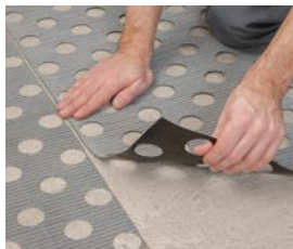
8 Nächste Platte der RAUTHERM SPEED plus renova Matte bündig ohne Überlappung installieren.
