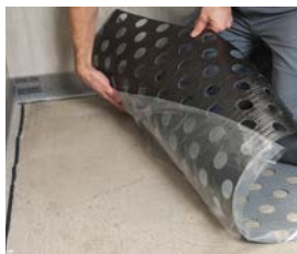
4 RAUTHERM SPEED plus renova Matte ausrichten, rückseitige Schutzfolie teilweise entfernen.
