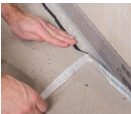
3 Folienfuß des Randdämmstreifens am Fußboden aufkleben.
