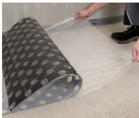
6 Restliche Schutzfolie von der RAUTHERM SPEED plus renova Matte entfernen.
